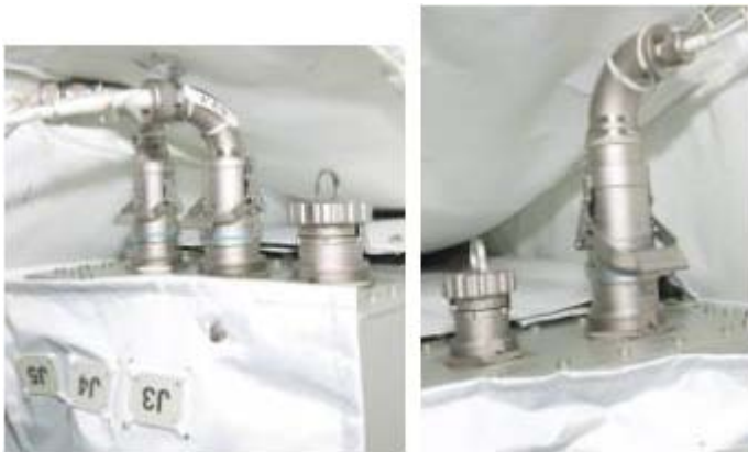
Figure 3.- Pump Module – NZGL.
